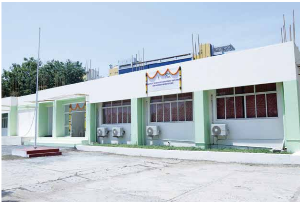
सीबा मुख्यालय में प्रयोगशाला भवन का विस्तार
