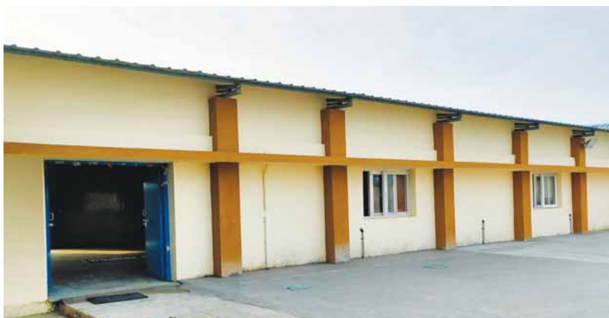
सीबा मुख्यालय में जेनरेटर रूम के आसपास पावर ब्लॉक और किनारे पर पत्थर लगाना
